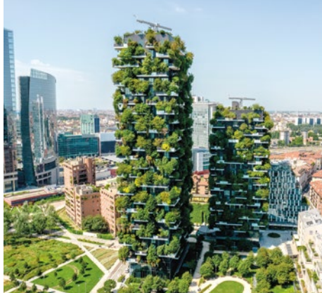
Begrünte Fassade: Bosco Verticale (senkrechter Wald), der 80 und 110 Meter hohe Hochhauskomplex in Mailand
